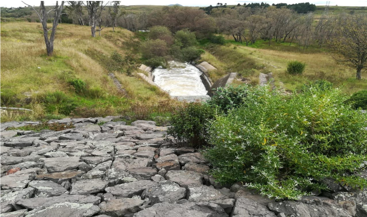
Foto 11: Salida de agua de la presa Ignacio Ramírez hacia el río Lerma
