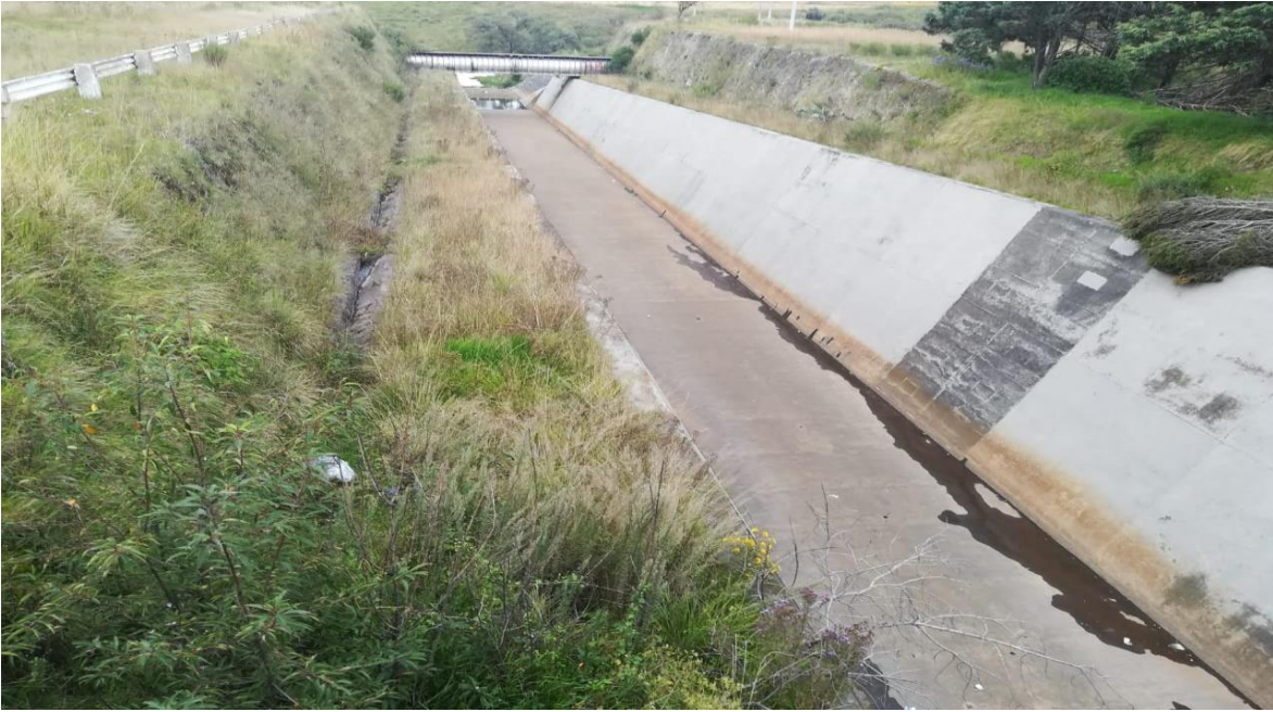
Foto 7: Vertedor de excedencias de la presa José Antonio Alzate (vista izquierda)
