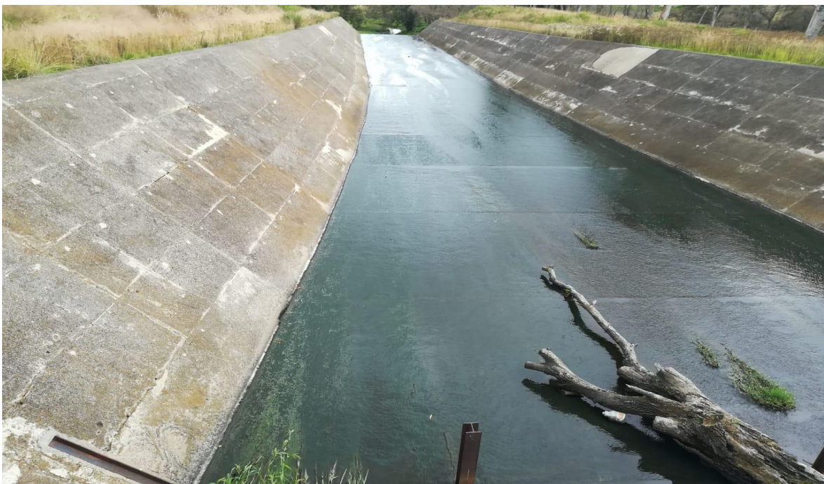
Foto 10: Vertedor de excedencias de la presa Ignacio Ramírez (Vista Izquierda)
