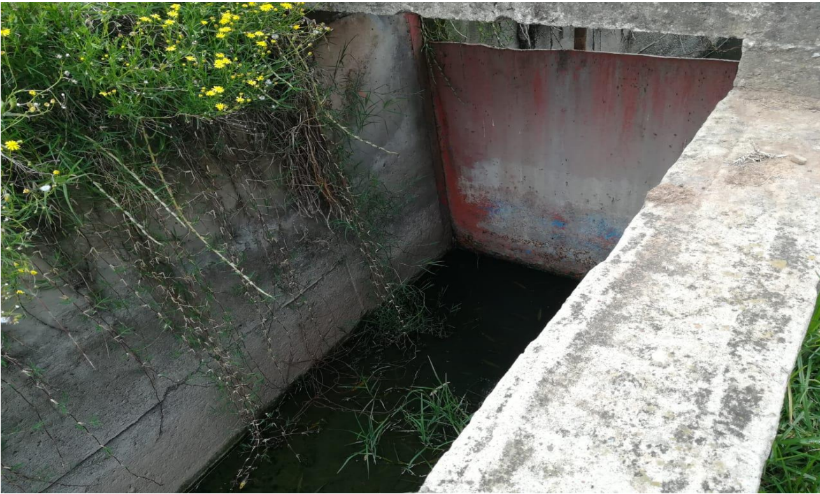
Foto 23: Obra de represa canal lateral
