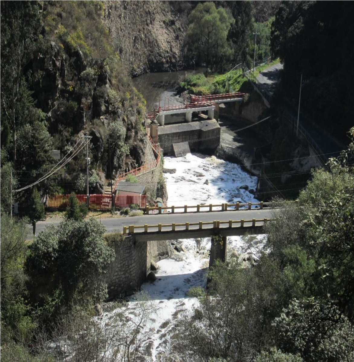
Foto 15. Vista aérea de la presa derivadora Andaró
