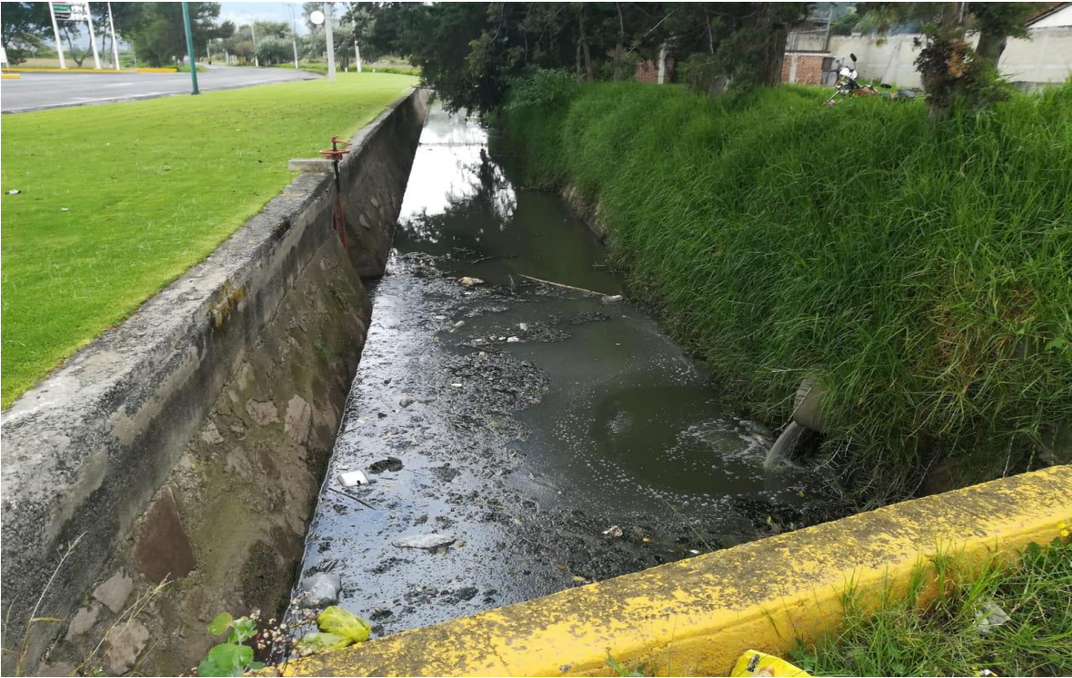
Foto 20: Canal principal margen derecha
