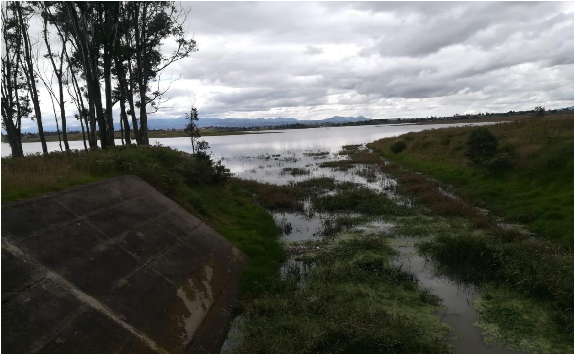
Foto 9: Vertedor de excedencias de la presa Ignacio Ramírez (Vista derecha)
