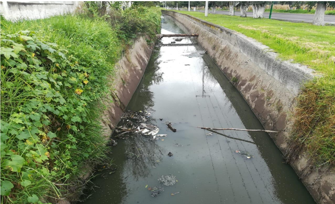
Foto 21: Canal principal margen derecha
