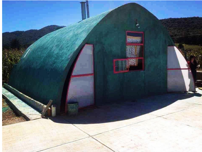
Ilustración 16 Hogar bioclimático de bóveda catenaria
