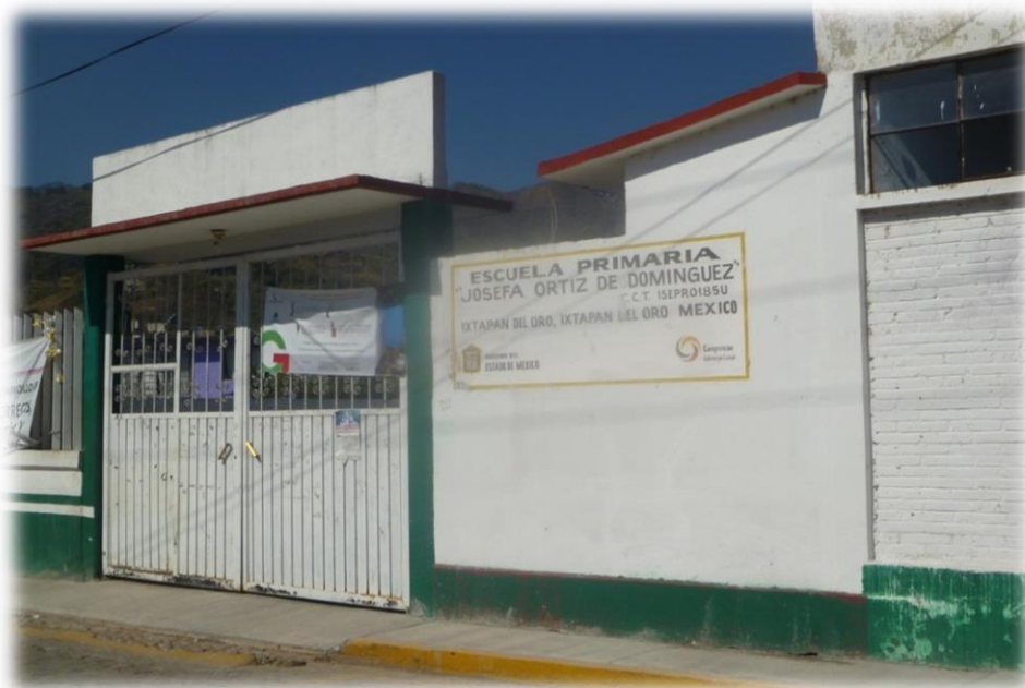
Fotografía 4 Fachada de la Escuela Primaria "Josefa Ortiz de Domínguez".
