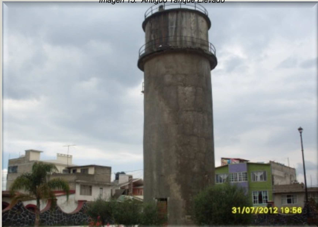
Imagen 15. Antiguo Tanque Elevado
