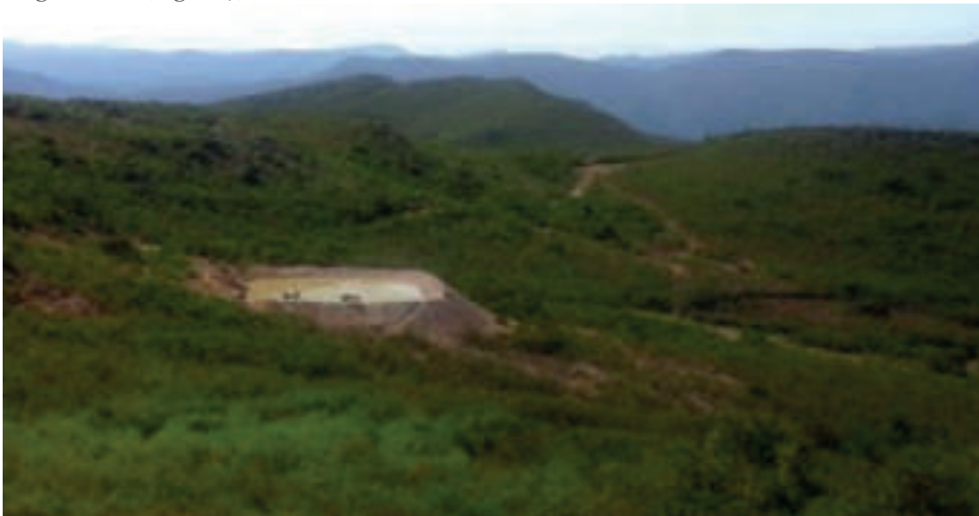
Figura 7. Construcción de atajados en el municipio de Pasorapa
